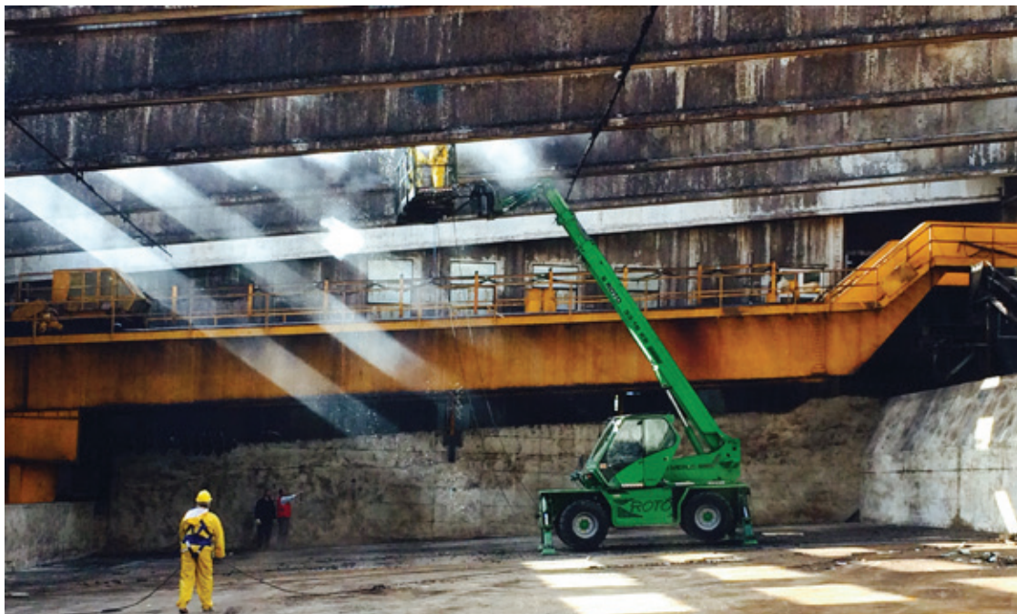
Bonifica travi e pareti con indropulitrice tramite mezzo in altezza
