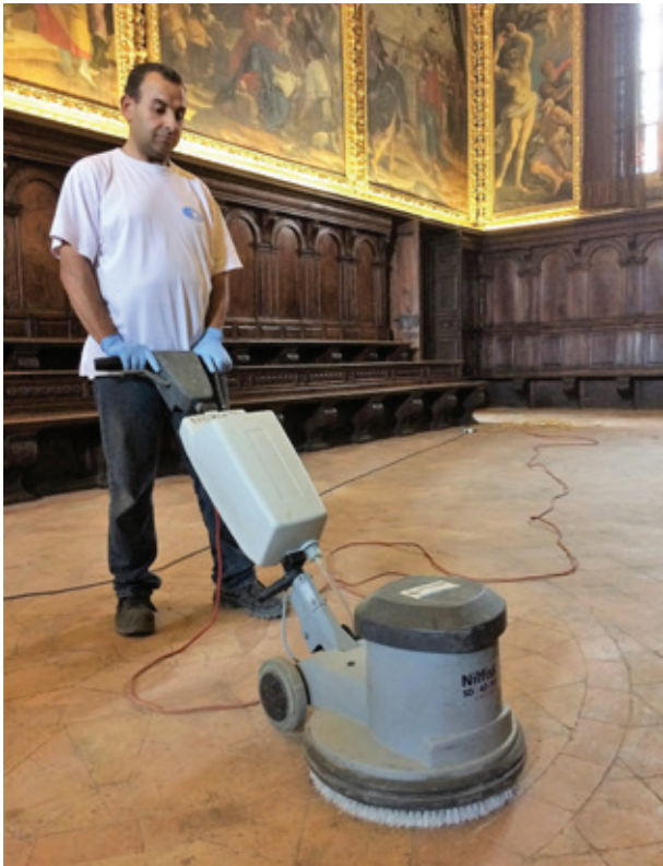
Tattamento di pavimento in cotto con monospazzola
