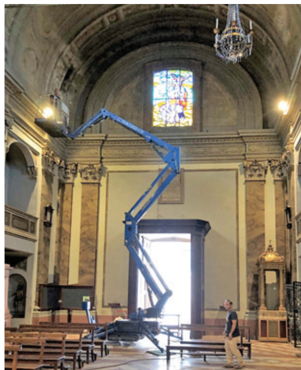
Pulizia e deragazione in altezza
