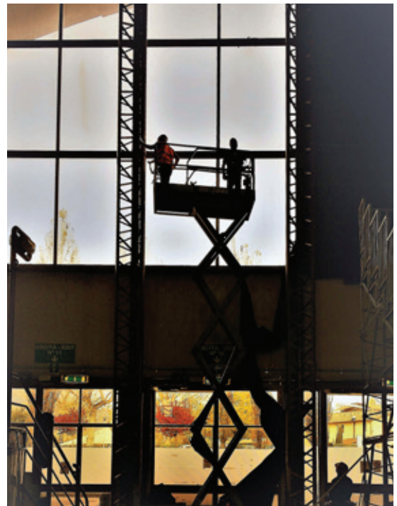
Pulizia esterna vetrate Palazzetto dello Sport Perugia
