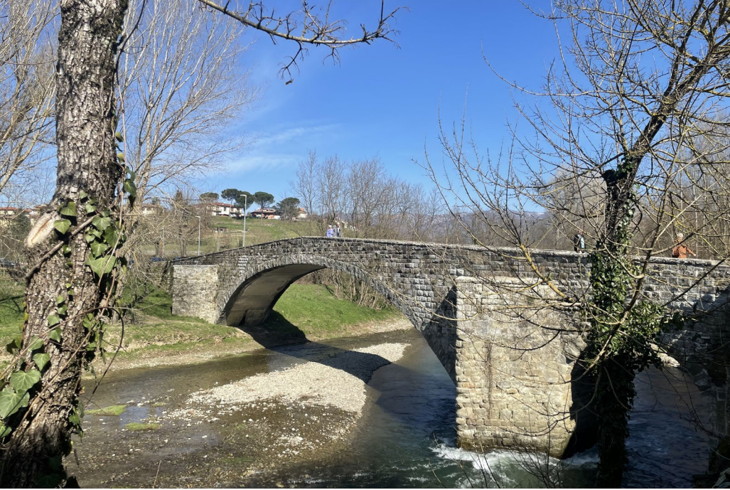
Ponte a Vicchio
