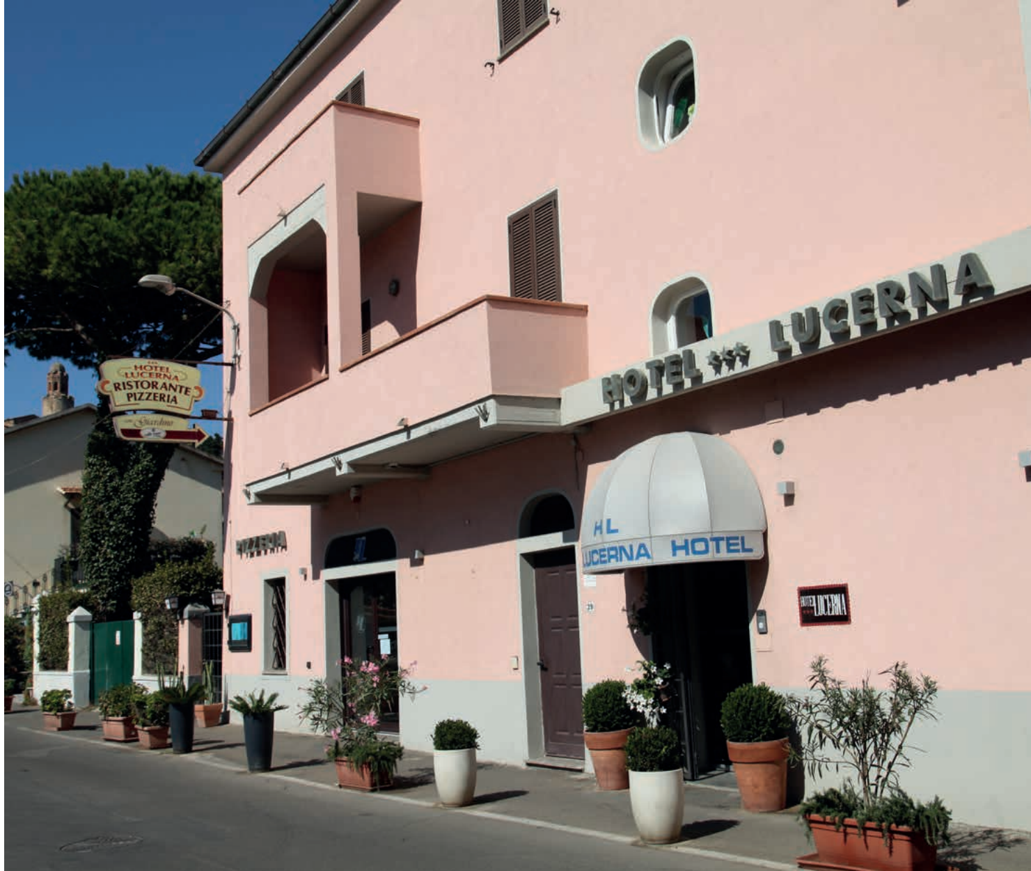
La struttura nel centro di Castiglione della Pescaia
