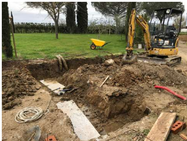
Scavo in preparazione dell'impianto
