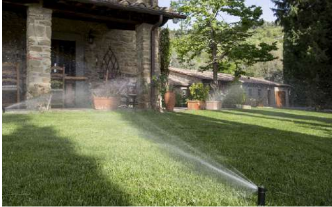
Un sistema di irrigazione appena completato
