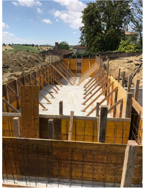
Inizio lavori per una piscina esterna
