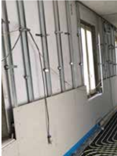
Costruzione di intercapedine
