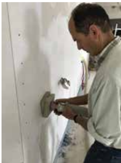
Insufflaggio di fibra di cellulosa
