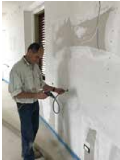
Video-ispezione prima e durante l'insufflaggio
