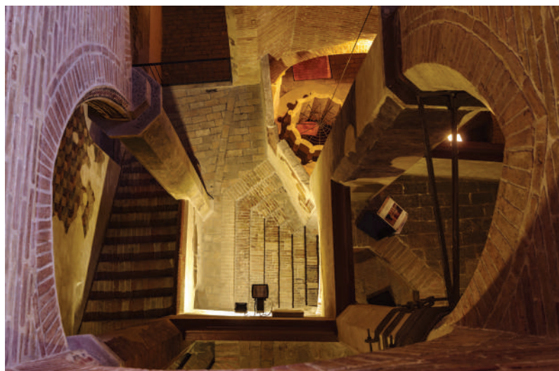
Palazzo Trinci, scala gotica e pozzo
