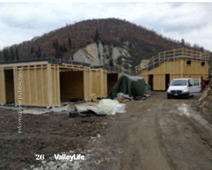
Struttura in legno a telaio pesante
