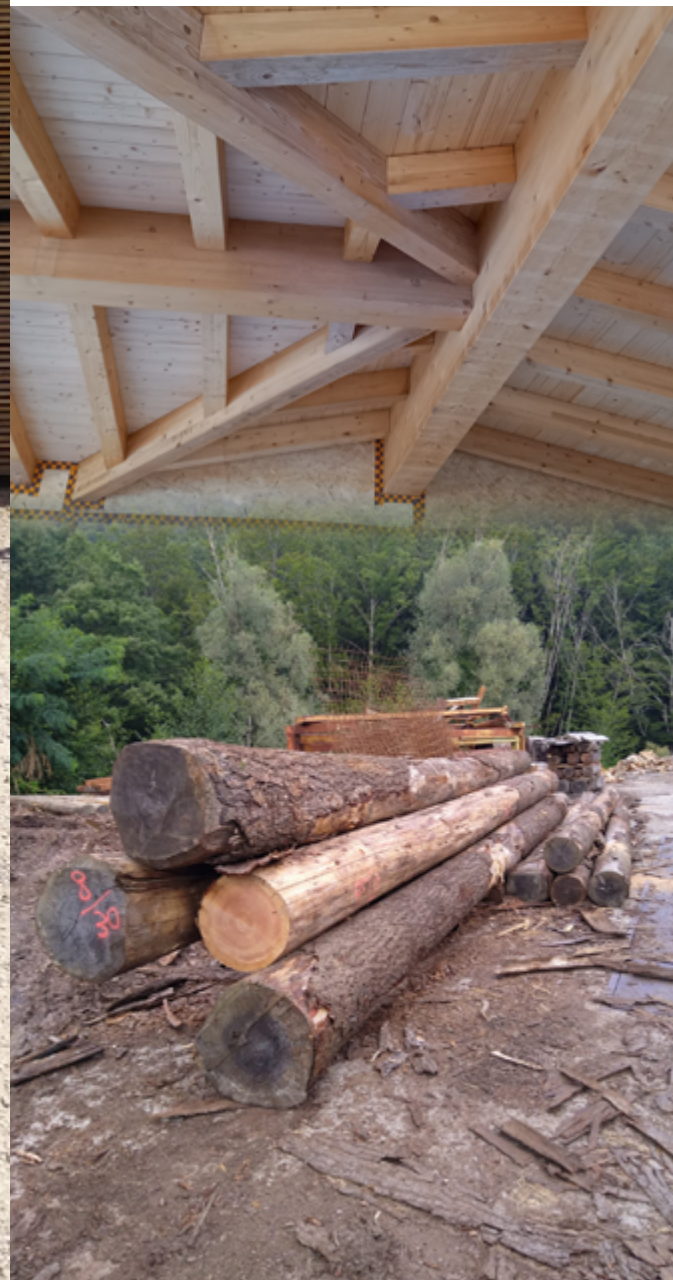
Tetti in legno
